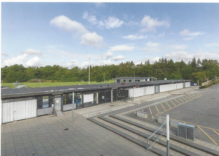
Det er på grunden, hvor den gamle omklædnings-barak ligger, at det nye medborgerhus skal ligge.
